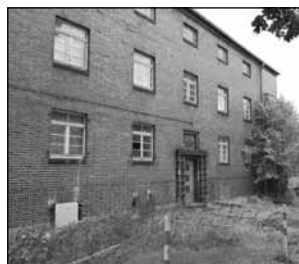
Im einstigen Bahnbetriebsgebäude an der Ebersdorfer Straße soll ein Projekt für kooperatives Wohnen entwickelt werden. Dafür werden noch interessierte Gruppen gesucht.
