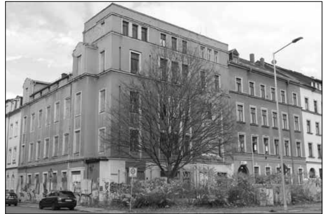
Das Gebäude Straße der Nationen 47, Ecke Zöllnerstraße, bedarf dringend einer Sanierung.
