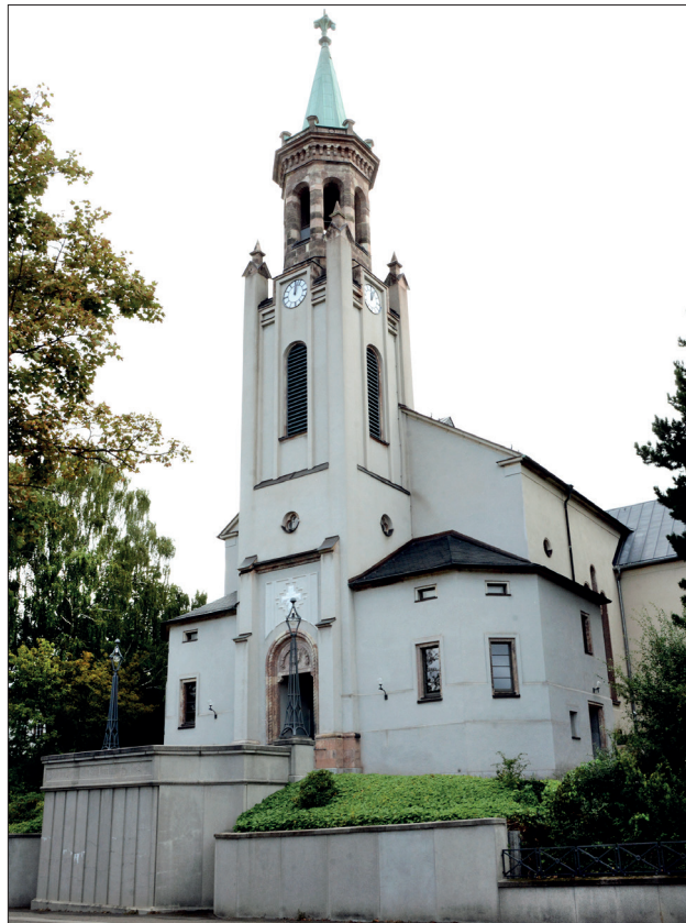
Seit fast zwei Jahren schmückt die Trinitatiskirche an der Frankenberger Straße eine neue Fassade.
