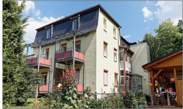
Von außen nicht sichtbar, sind die Arbeiten an der neuen Tagespflege im Inneren der Villa bereits in vollem Gange.
