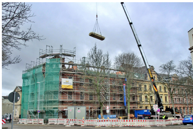
Die Sanierung von stadtteilprägenden Wohngebäuden wird fortgesetzt; ehemals Bäckerei Wagner, Frankenberger Straße 35.
